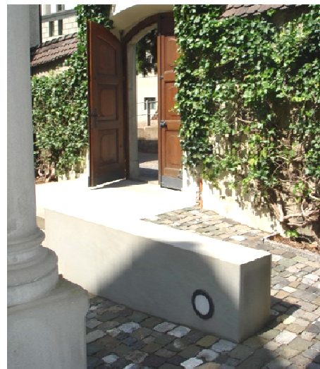
Eingangshof mit Rampe nach dem Umbau
