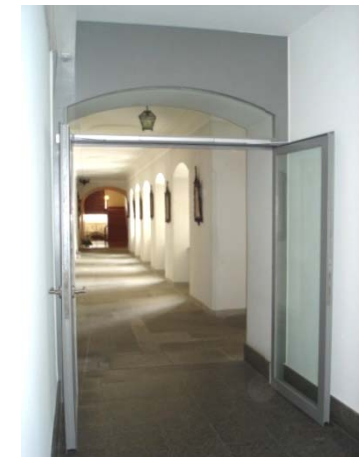
Um Klosteranlage und Kulturgut zu schützen werden mit Brandschutztüren Brandabschnitte eingeführt.
