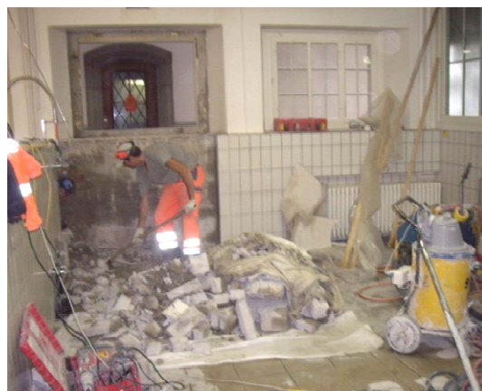
Bauarbeiten dritte Etappe im Untergeschoss
